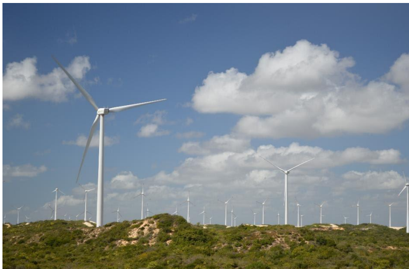
Figura 2 —Parte dos aerogeradores do Parque Arizona 1 e do RN-15 (ao fundo)
